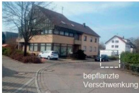
Dorfwiesenstraße, Ecke Kirchstraße – Kurvensituation
